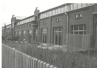
Will -O.-Darby-Kaserne Fürth: Zu Wohnungen umgebaute Pferdeställe (Foto: Dürsch)
